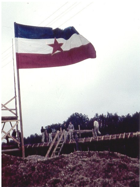
Die 17 Mann starke Arbeitsgruppe der jugoslawischen Jungkommunisten hatte es sich nicht nehmen lassen an der Baustelle ihre Fahne zu hissen
