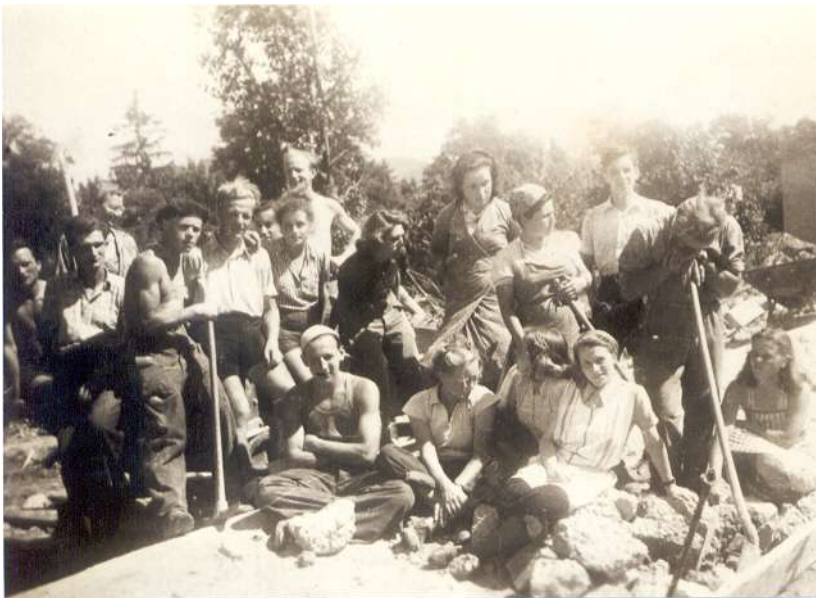
Die aufgeräumte Baustelle, die Lagermannschaft und ein Ausflug zum Feldberg.
