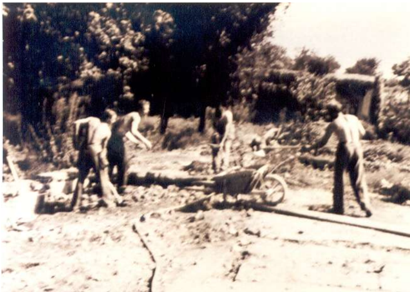
Die alten Backsteine wurden geborgen, von Mörtelresten gesäubert und zur erneuten Verwendung beim Wiederaufbau gestapelt.
