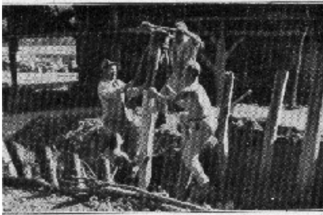
Rietheim (Aargau) 1931: Verbauung am Bachbett.
